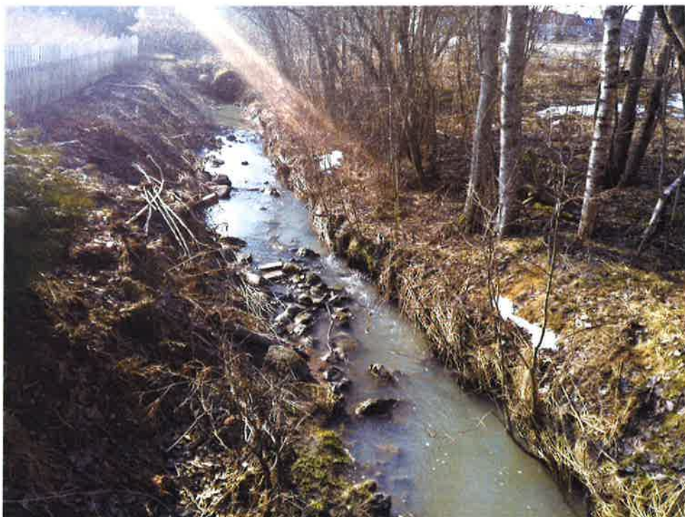
Figur 2: Bekkens innløp med stikkrenne øverst i bildet. Bildet viser opprinnelig terreng i øverste del av den planlagte fangdammen. Bildet er tatt fra eksisterende gangbro.
