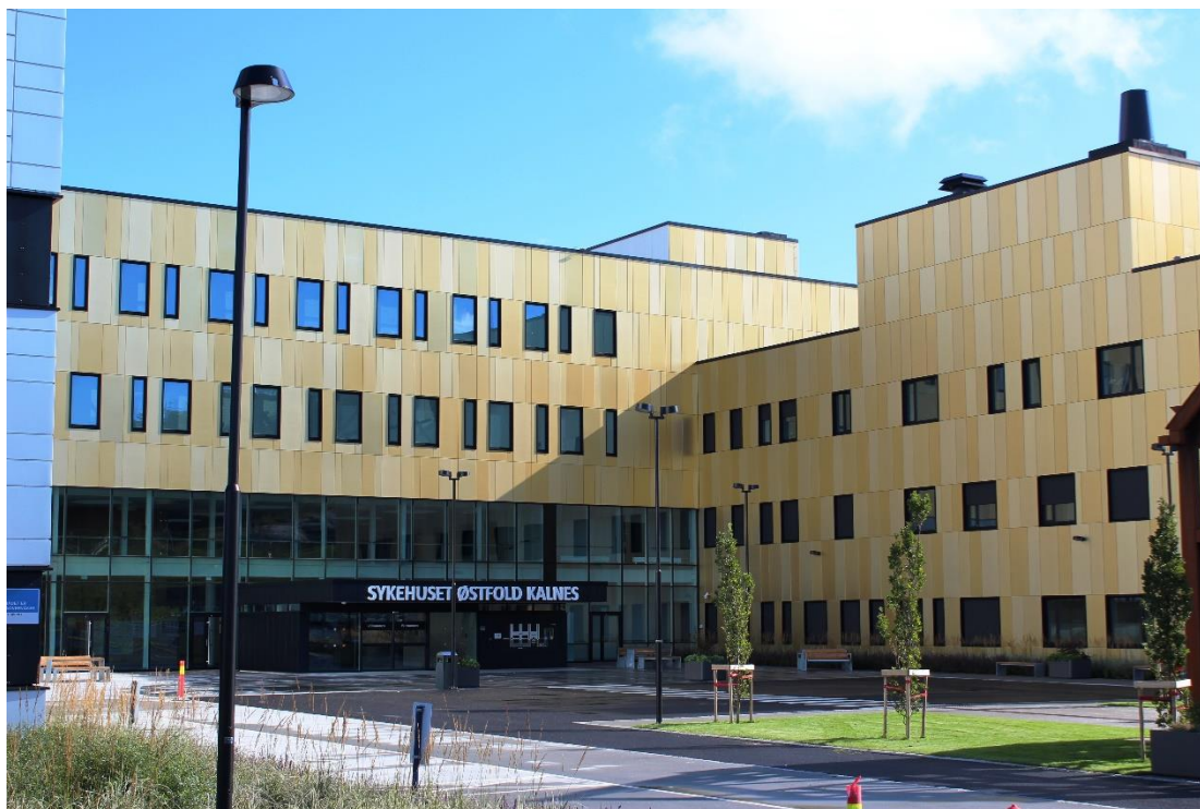
Plassmangel går også ut over kliniske behandlingsstudier. Bildet er av Sykehuset Østfold Kalnes. Foto: Sykehuset Østfold HF.
